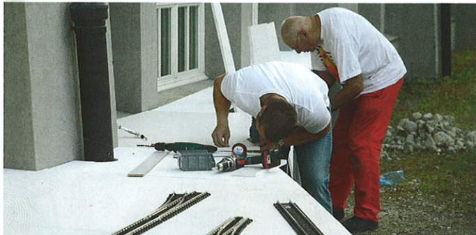
Trassen für die Aussenanlage.
